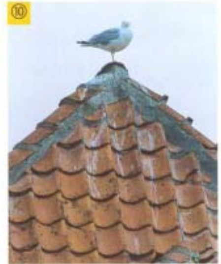
Grünbildung auf geneigten Dachflächen bei Häufung von mehreren Grünbildungsfaktoren
